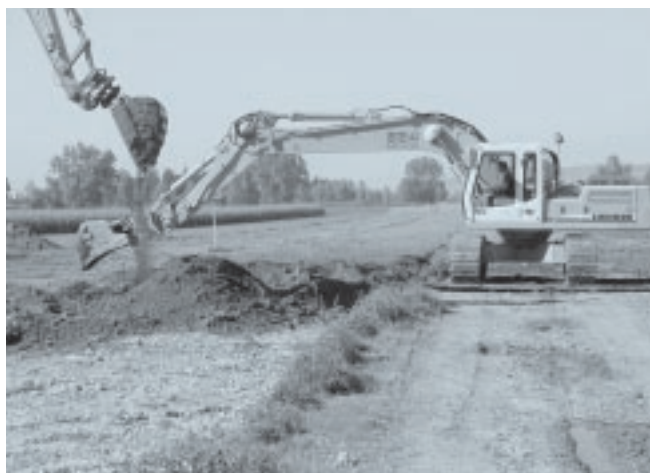
Lockerer schüttfähiger Humus wird zur Rekultivierung eingebracht. Da der Unterboden nach einem Niederschlag feucht ist, arbeiten die Maschinen auf Baggermatratzen, damit der Boden nicht verdichtet wird.
