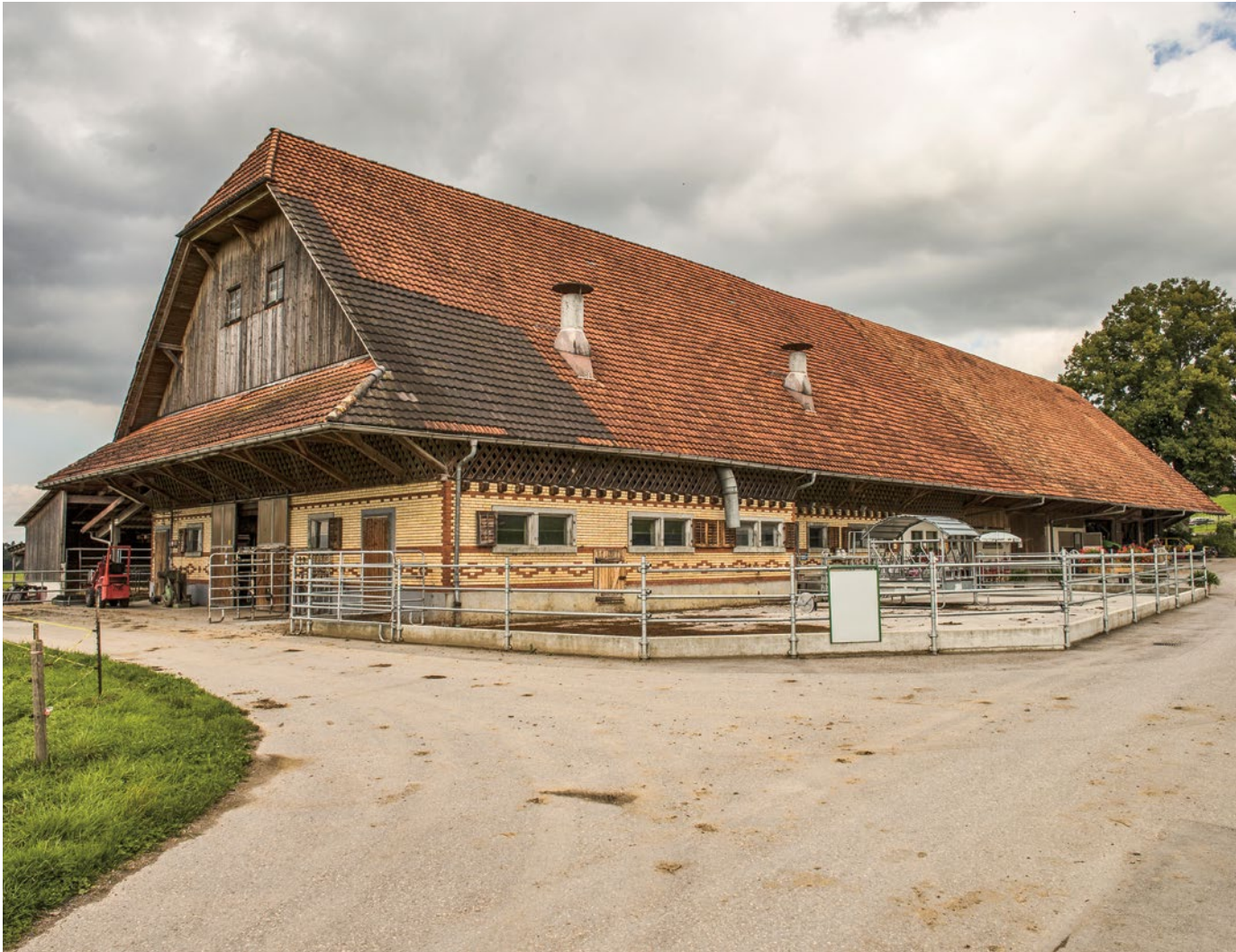
Eindrückliches Beispiel einer traditionellen Stallscheune, Cham
