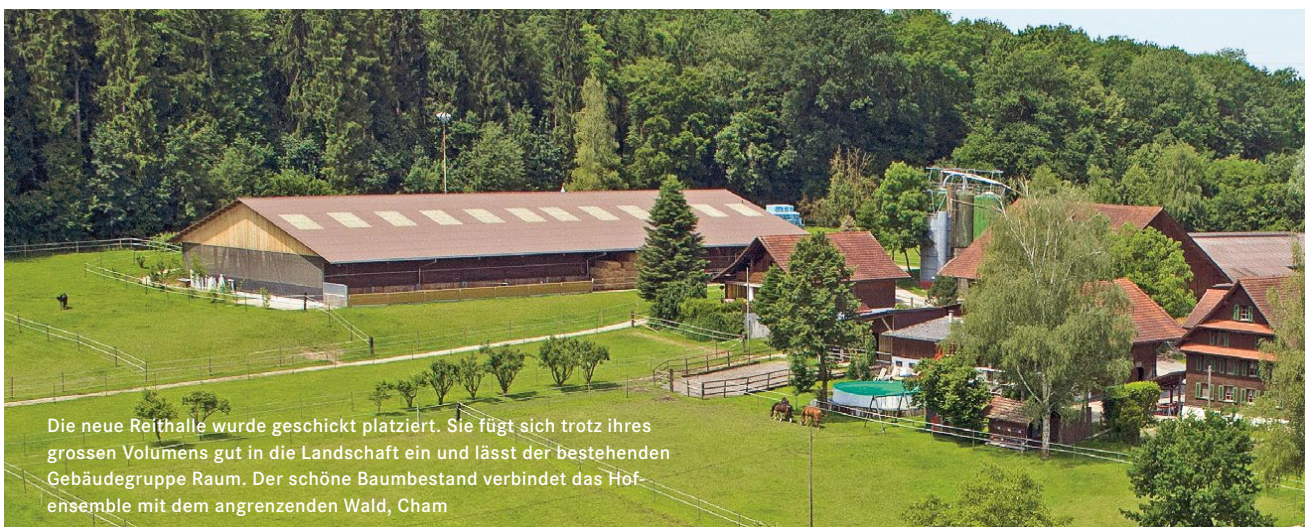
Die verschiedenen Neubauten wurden sehr gut ins Gelände gesetzt. Mit ihren einheitlichen und klaren Formen und Materialien bilden sie ein gelungenes neues Hofensemble, Rotkreuz
