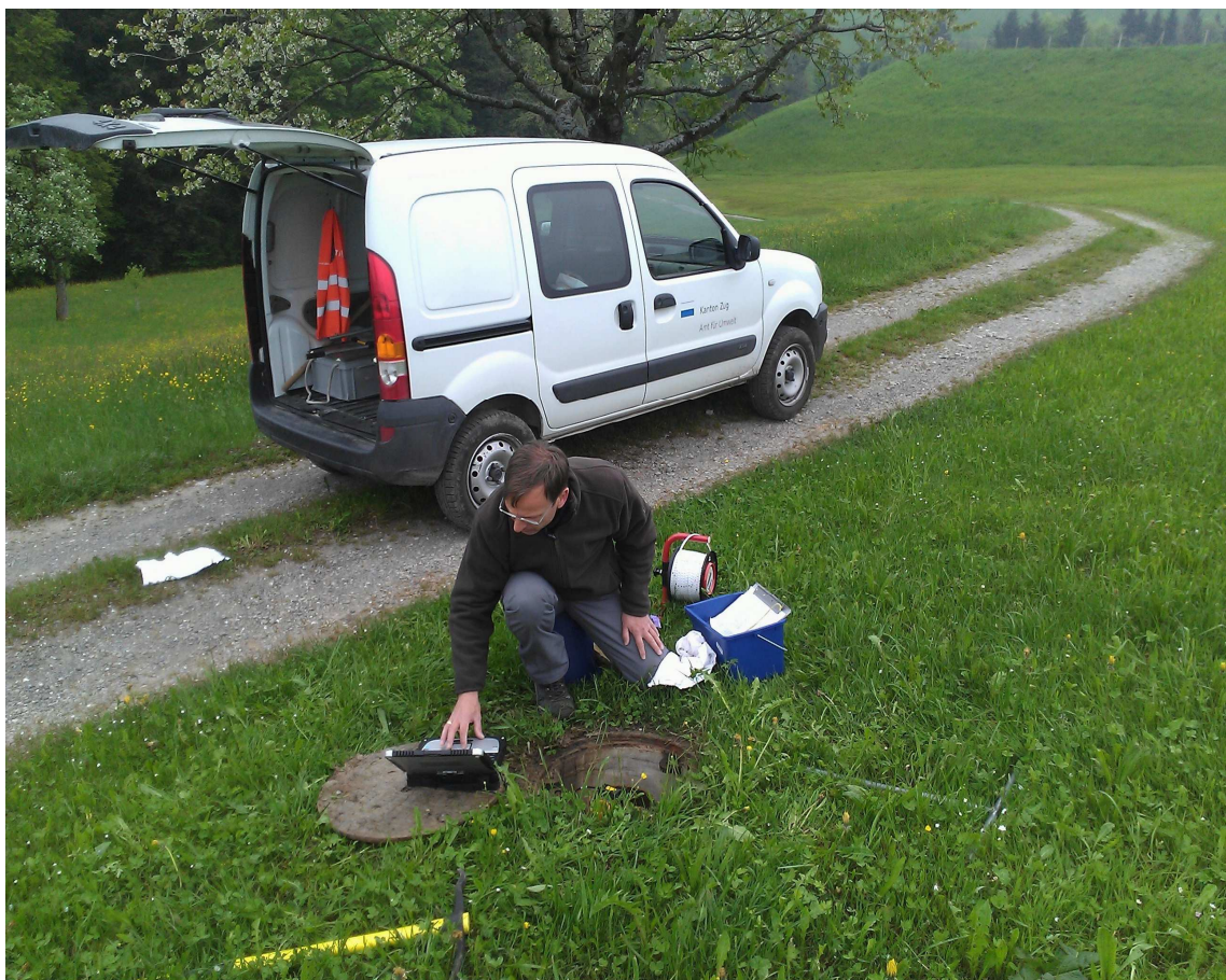
Grundwassermessstelle Kanton Zug
