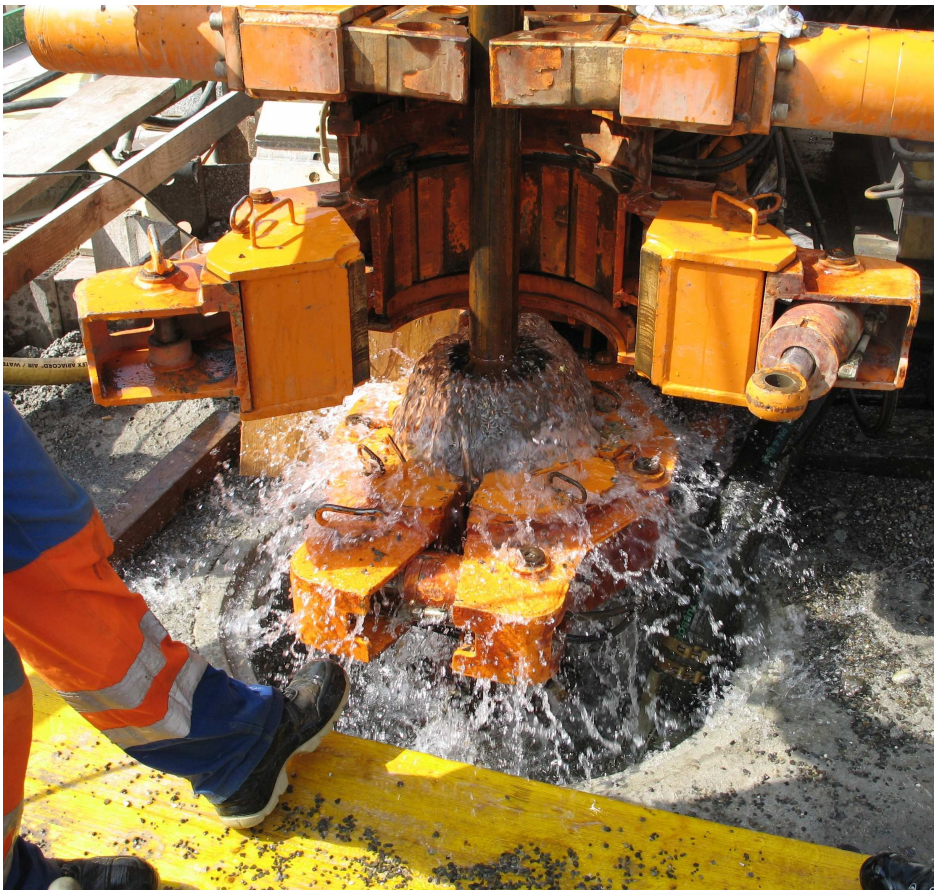
Grundwasserbohrung Kirchgemeindehaus Zug
