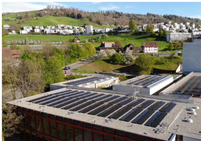
Kantonsschule Zug: Bei Flachdachsaniierungen Photovoltaikanlagen ergänzen
