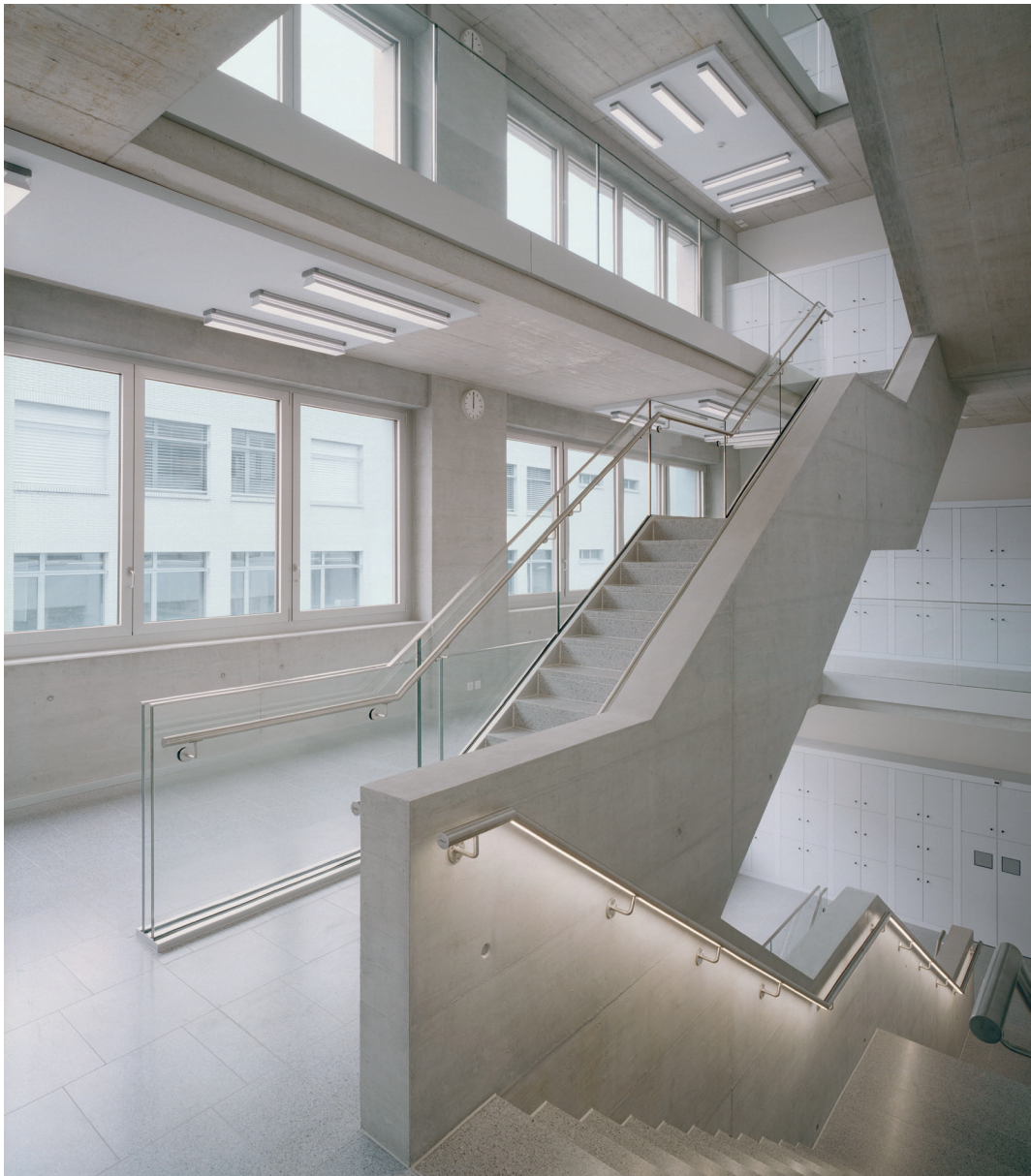
Die Geschosse sind durch einläufige Treppen mit Zwischenpodesten untereinander verbunden.
